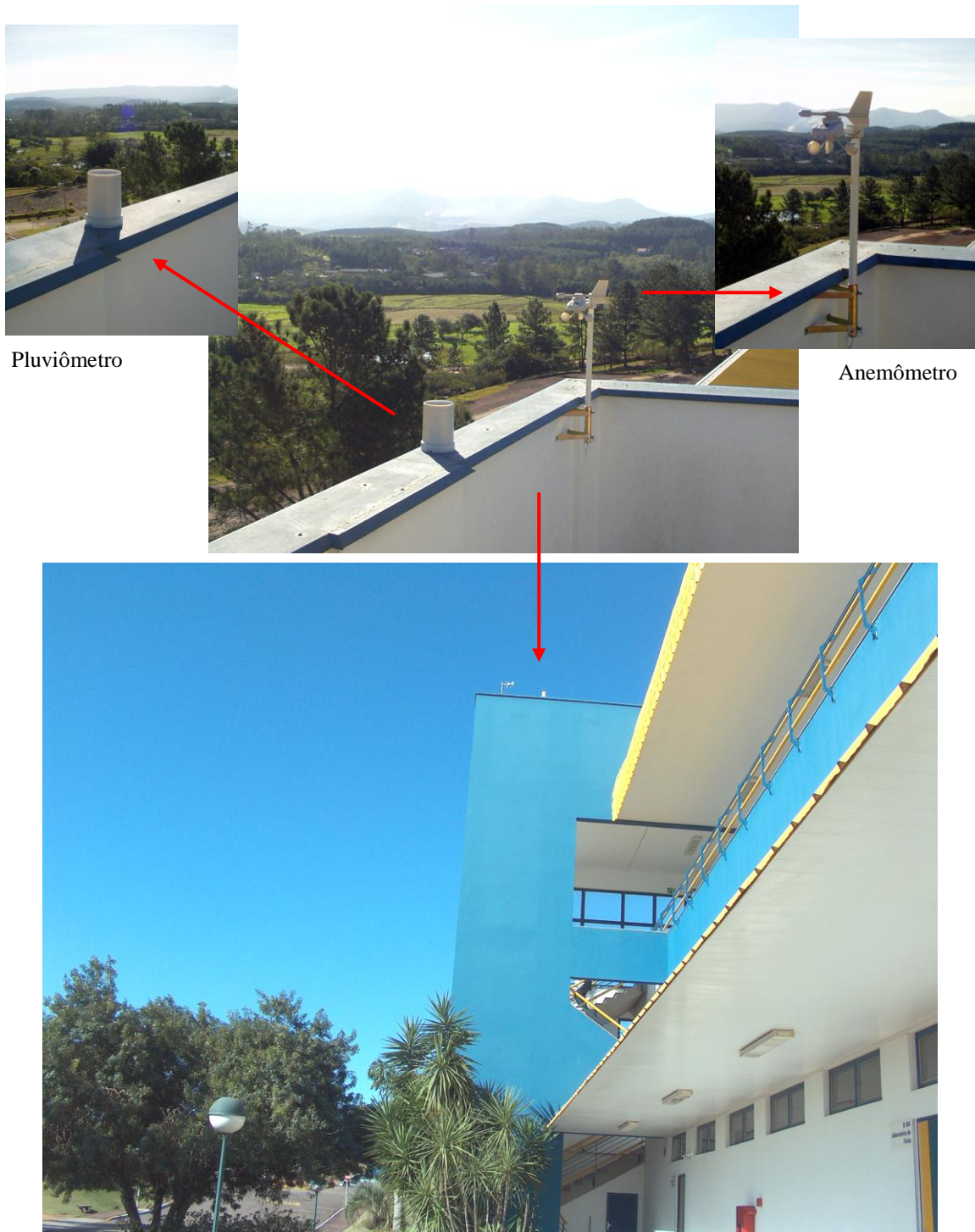
Figura 3 – Local de implantação dos sensores do Anemômetro e Pluviômetro (Prédio D)
