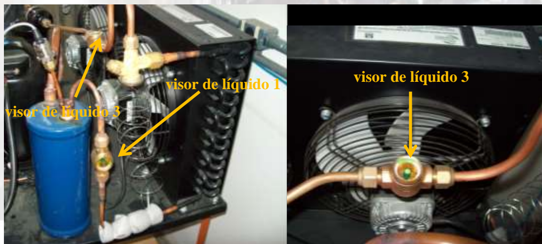
Figura 28 – Visores de líquido instalados e identificados conforme posição na numeração da Figura 2.
